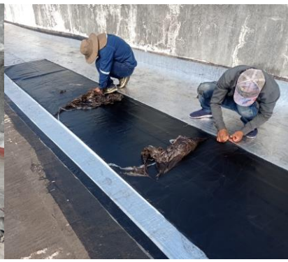
Colocado de la membrana asfáltica
